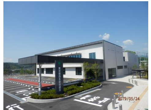
西多摩保健所新庁舎
